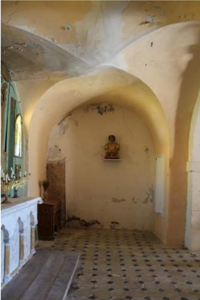
La voûte de la chapelle du bas coté et son importante déformation en clés (il s'agit sans doute la chapelle primitive)
