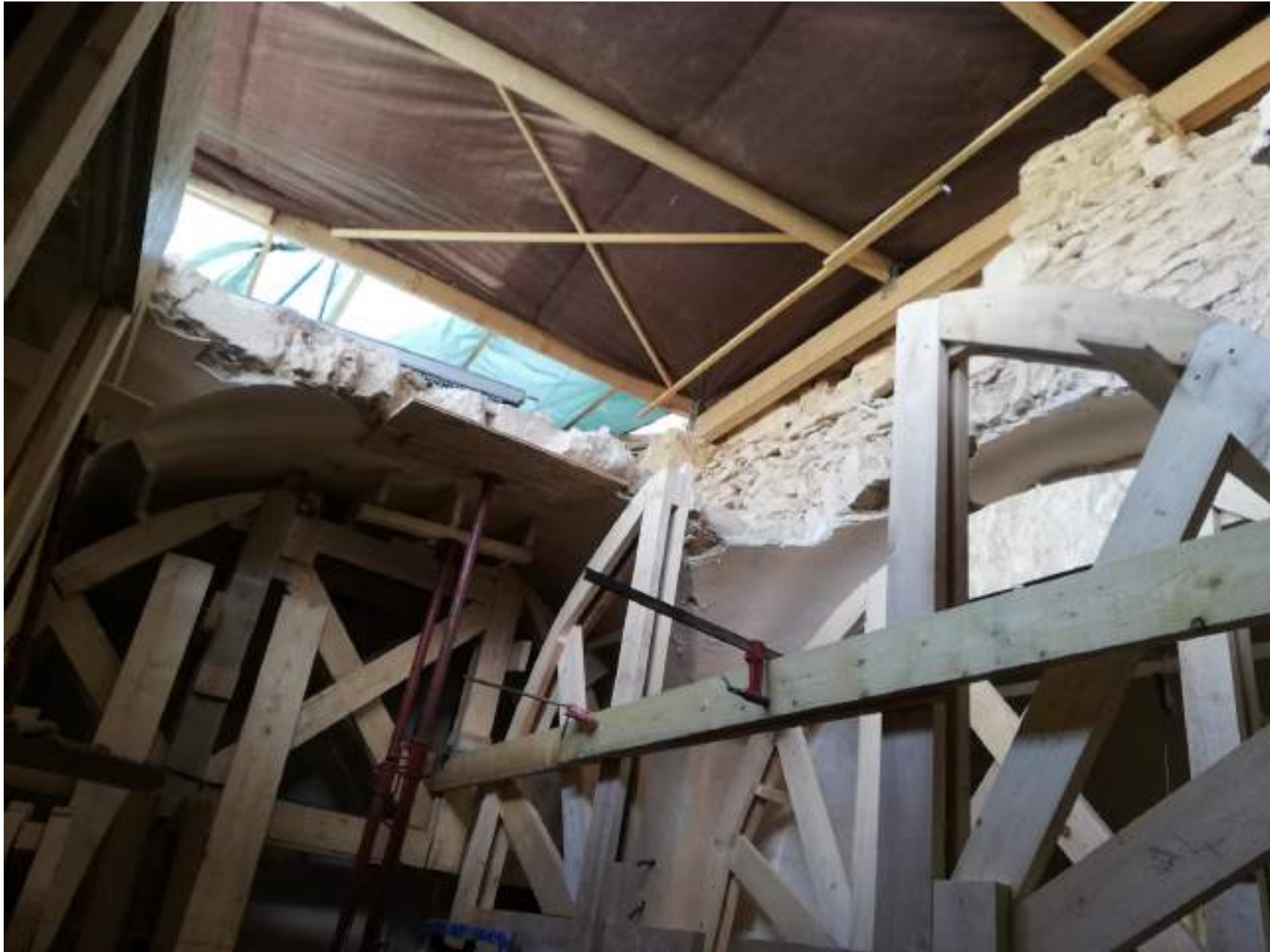
Le trou laissé par la voute démontée
