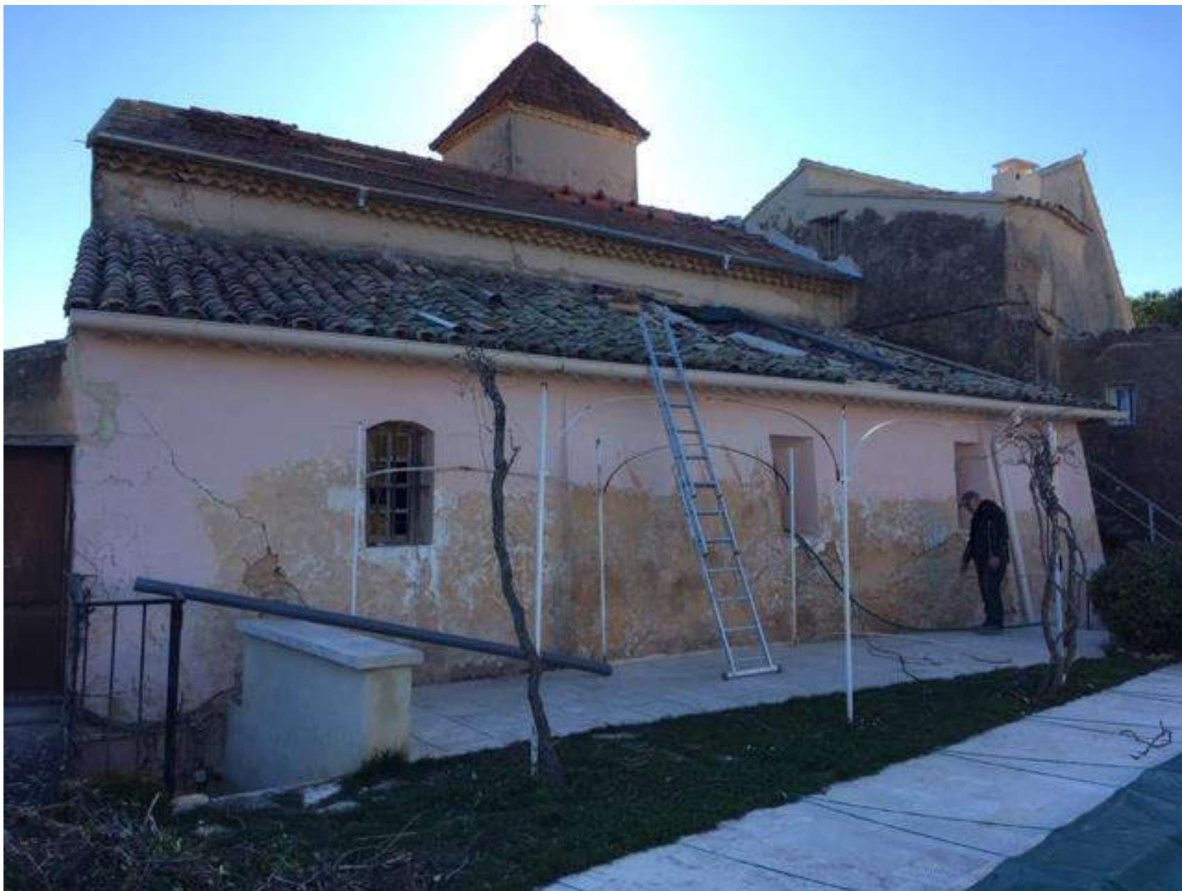
Réfection des enduits du mur gouttereau de la chapelle du bas coté
