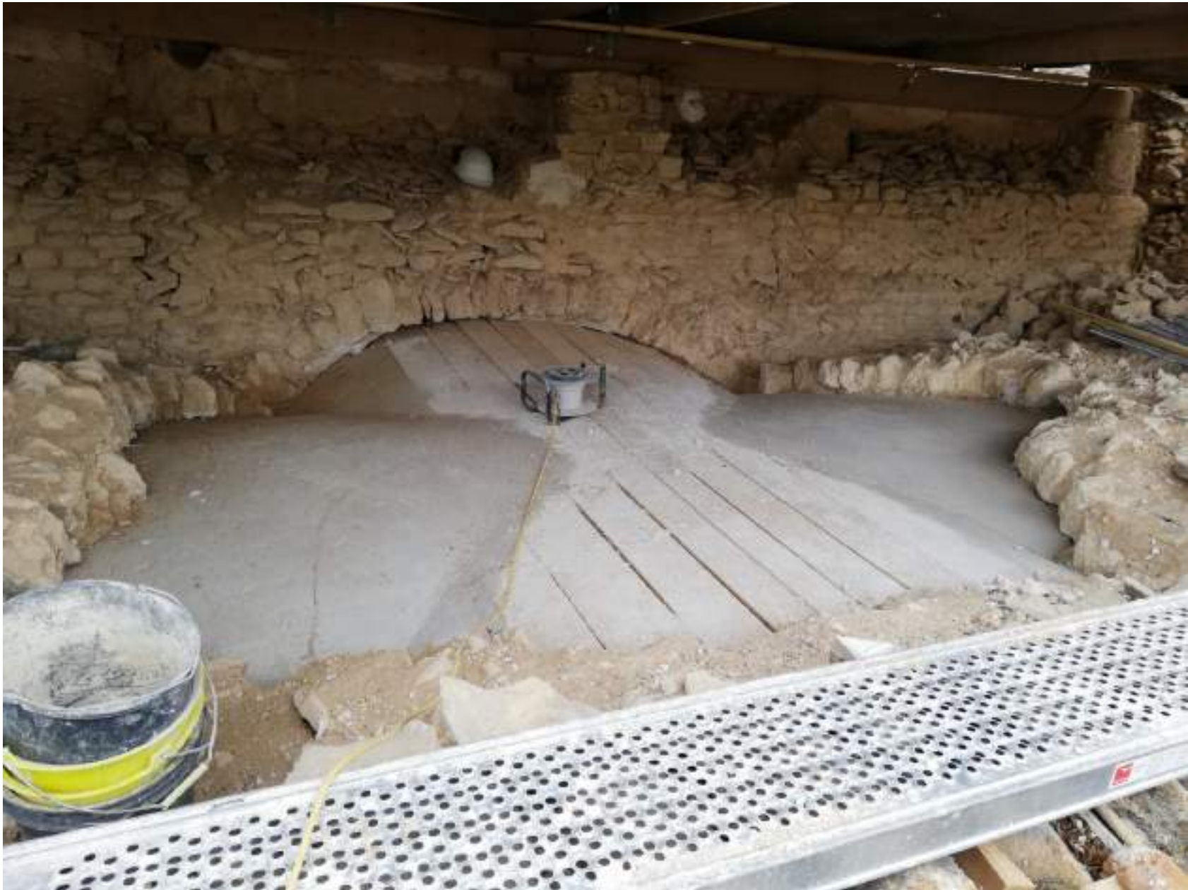
Platelage en vue du remontage de la voute
