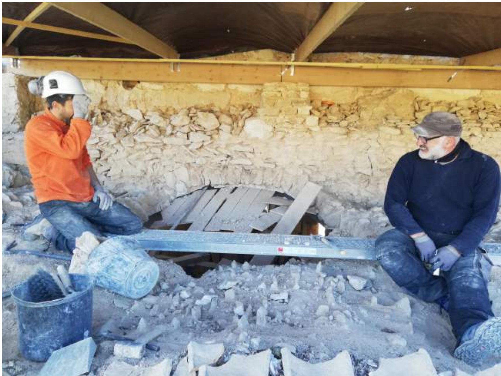
Démontage de la voute déformée
