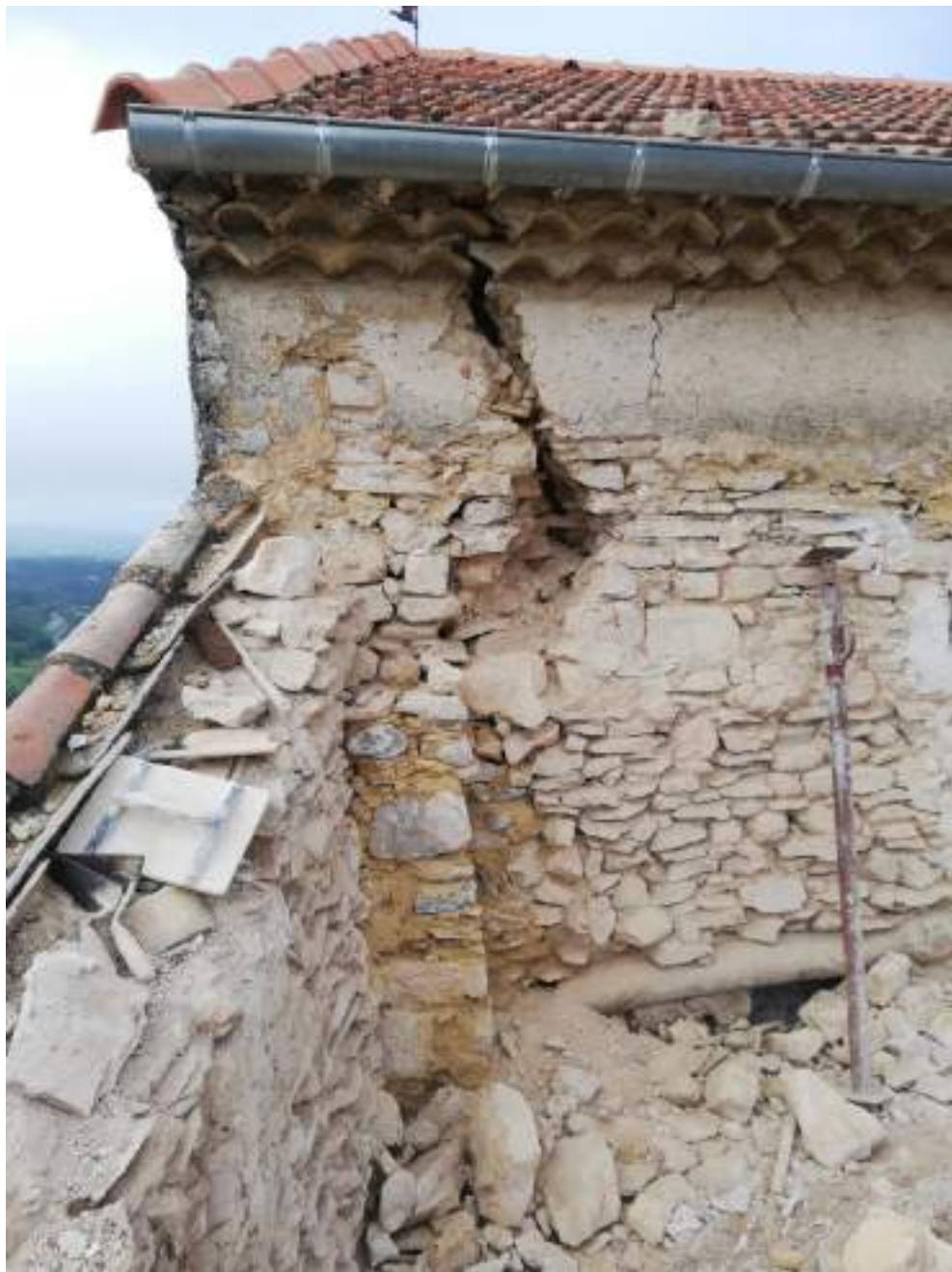
Surprise du chantier : une belle fissure à reprendre
