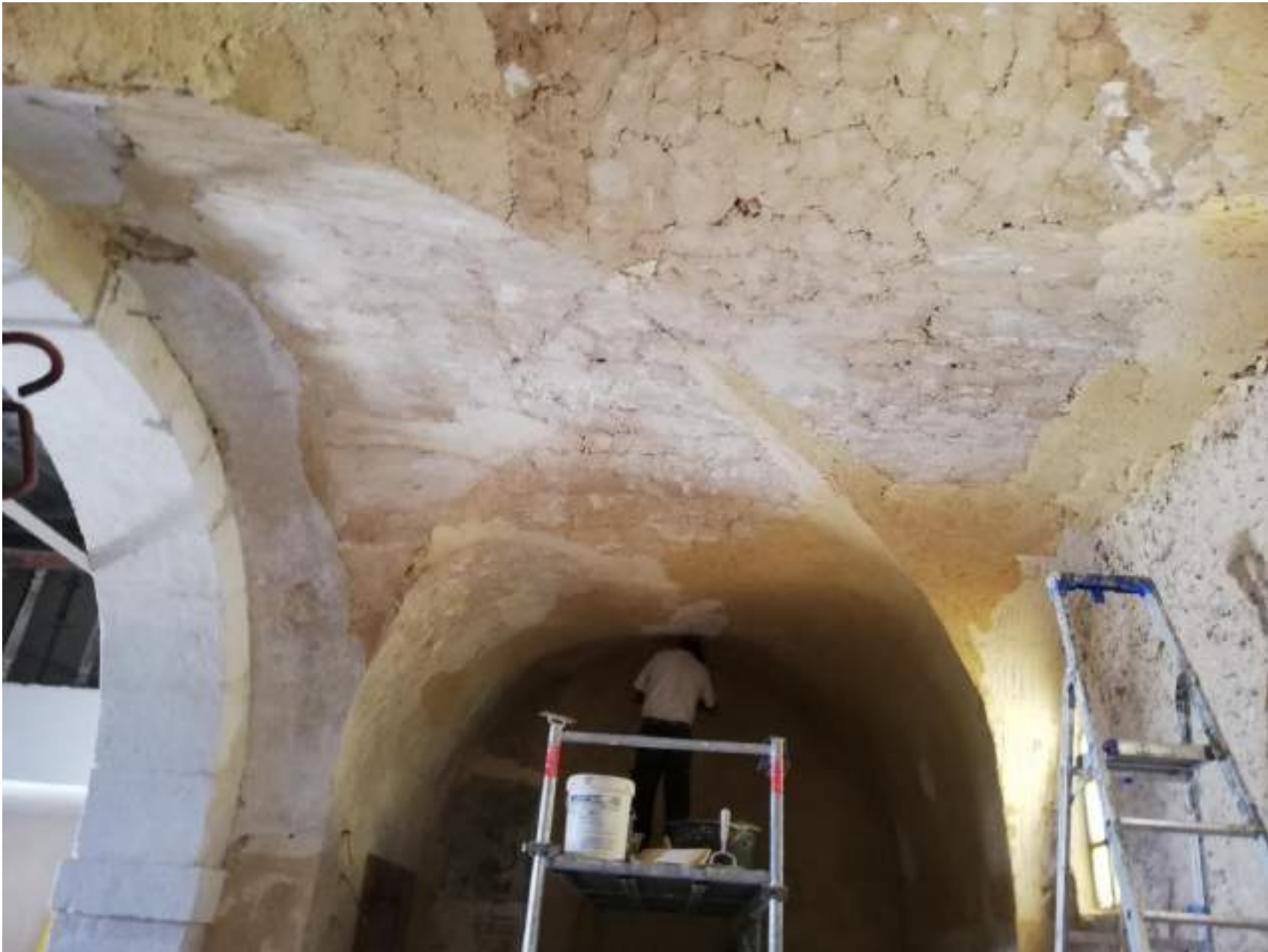
La voute d'arête « neuve » après dépose des cintres
