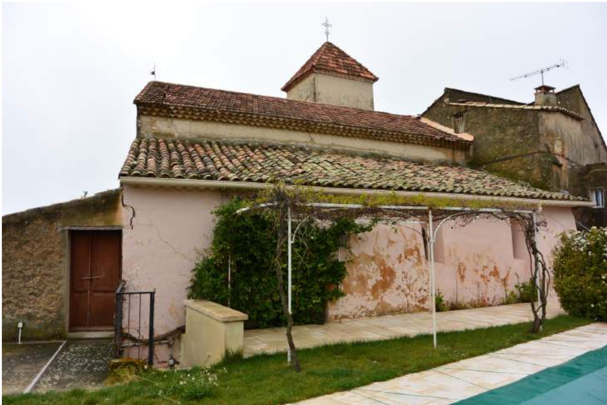
Le mur gouttereau de la chapelle du bas coté avant travaux
