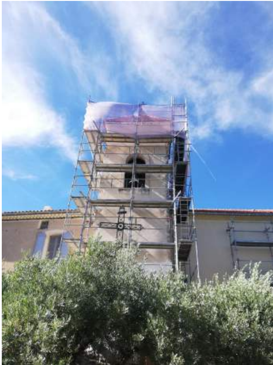
Les travaux extérieurs : La reprise des enduits
