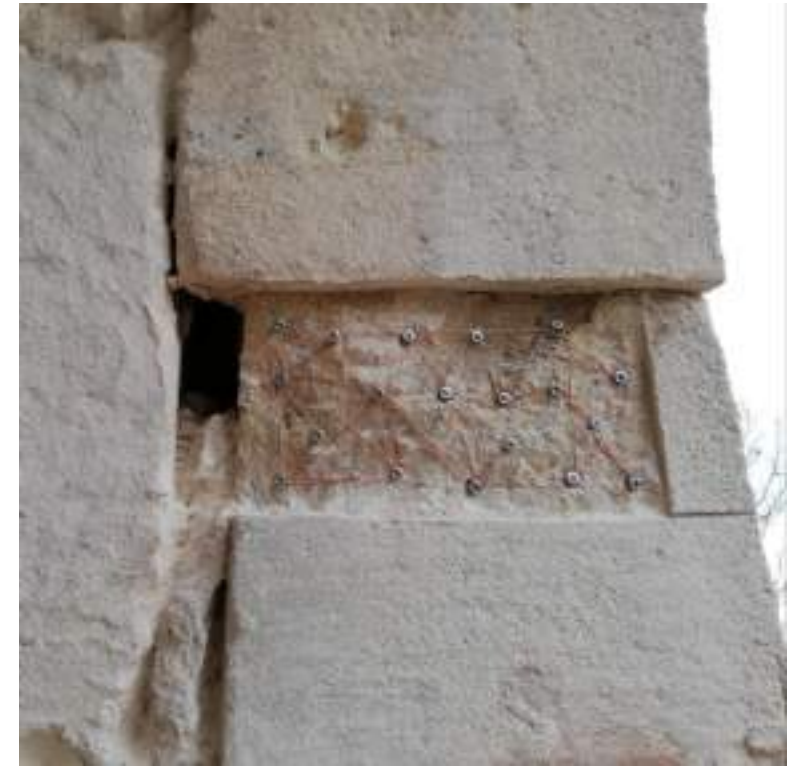
Découverte d'un bénitier dans l'épaisseur de la maçonnerie, réfection de la porte romane et réparation d'une pierre.
