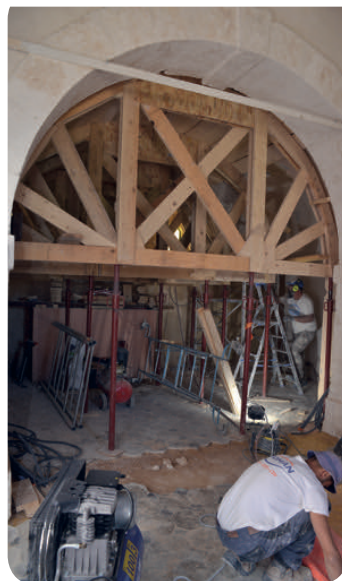
Une étape essentielle de la réfection de la voûte après la pose d'un coffrage en bois.
