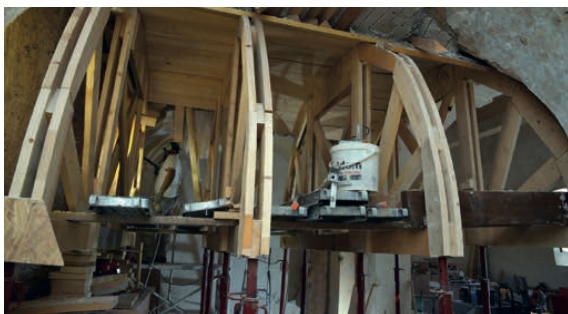
Une étape essentielle de la réfection de la voûte après la pose d'un coffrage en bois.
