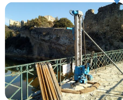
Opération de carottage (forage d'exploration)
