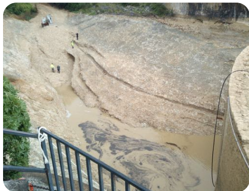
Opération de curage du barrage
