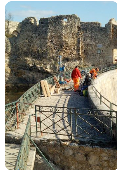
Opération de carottage (forage d'exploration)
